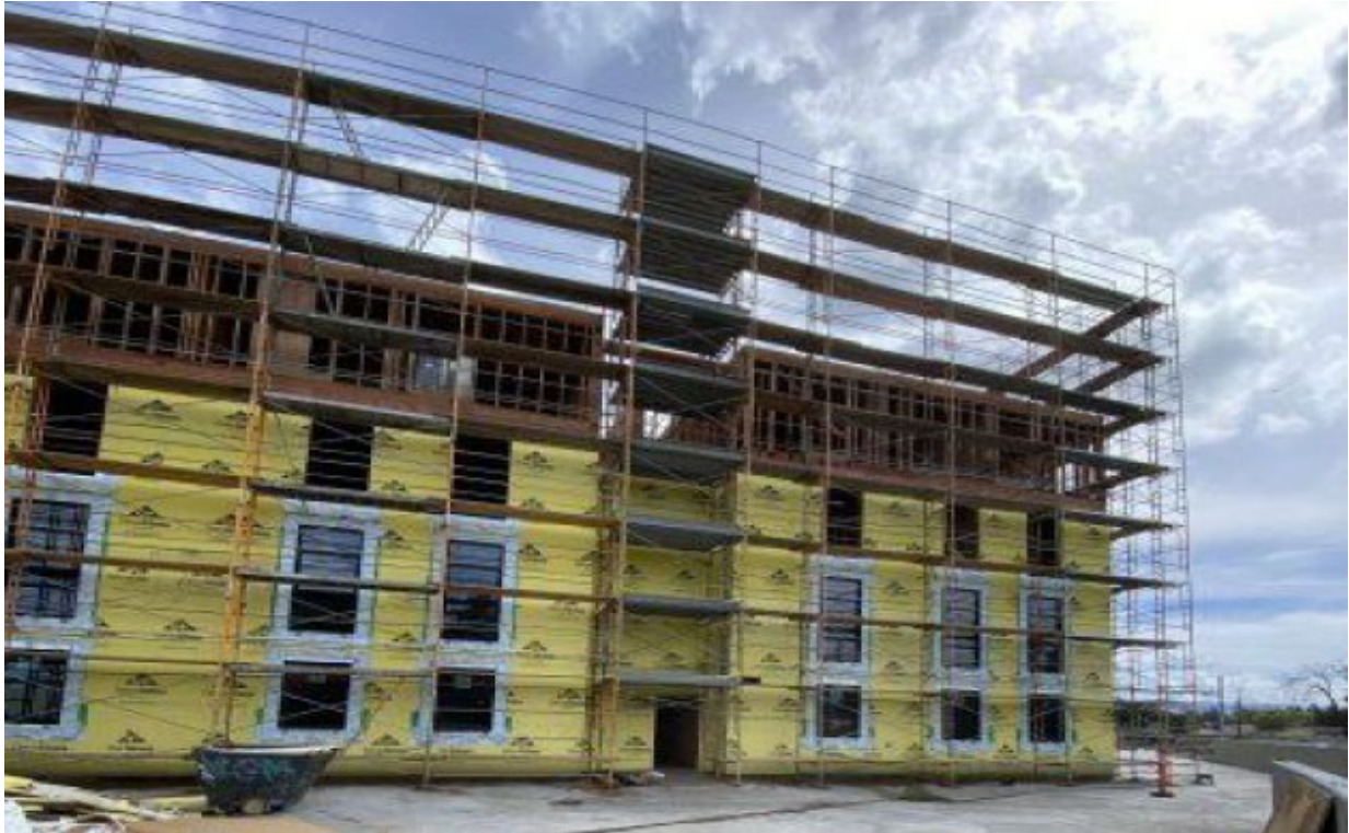
Figura 3 - Progreso de la instalación de ventanas en el edificio sur, marzo de 2024.
