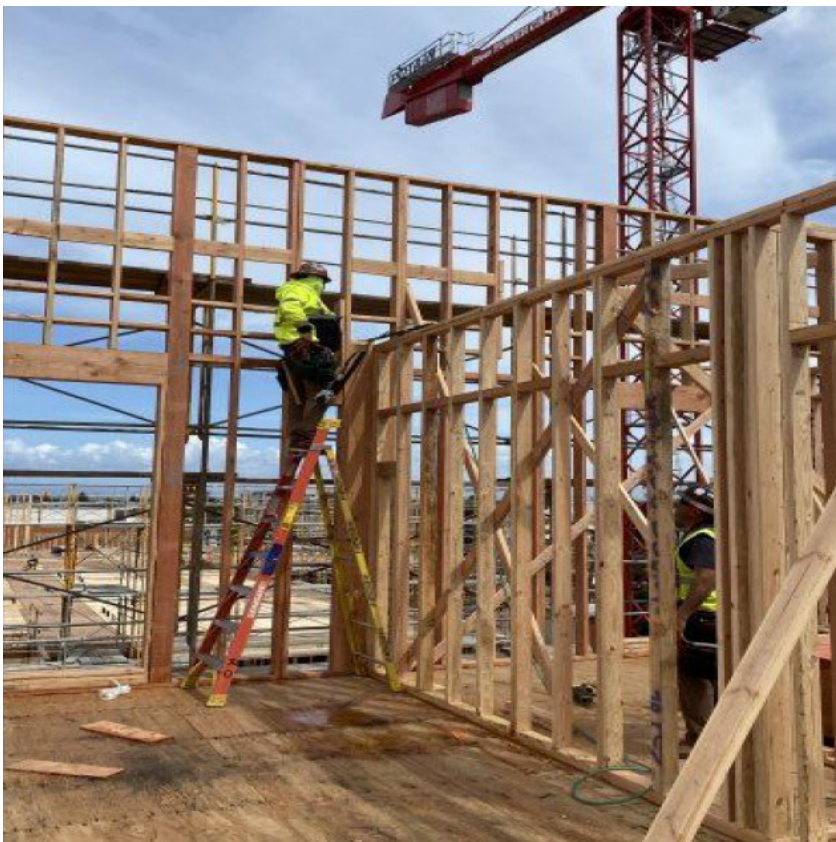
Figura 4 - Progreso de la instalación del edificio sur, marzo de 2024.
